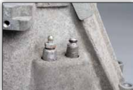
Снимка 3: Демонтаж на старата конструкция
