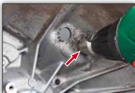
Снимка 5: пробиване на отворите
