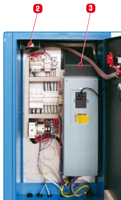
Quadro elettrico e inverter.
