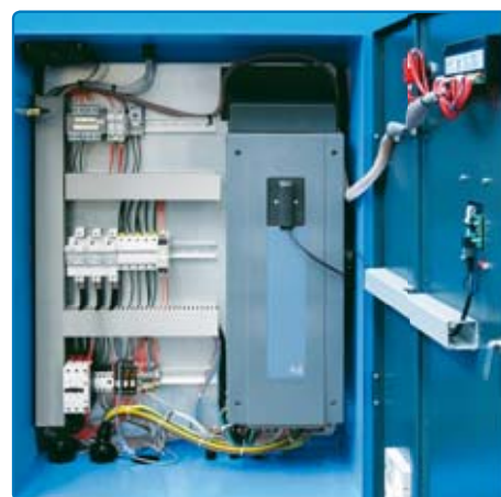
Quadro elettrico e inverter.
