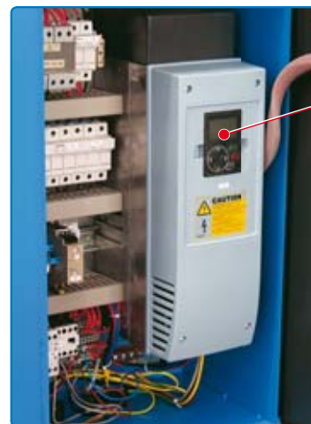
Quadro elettrico e inverter.
