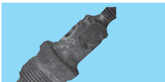
Силна корозия (Релефна, ронеща се, люспеста повърхост)
