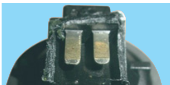
Повреден електрически конектор
